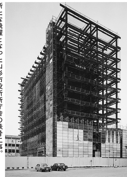
新たな飛躍となった山形市役所新庁舎の鉄骨工事。
