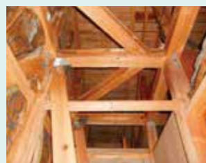
接合金物による補強
