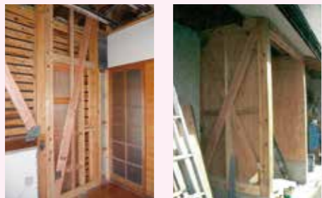
筋かいや耐震壁などを設置する耐震改修工事費
