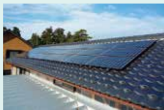
太陽光発電設備の設置
