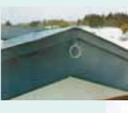
命綱を固定する金具の設置
