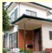
外壁の改修、塗装
