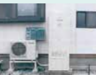
高効率給湯器に更新
