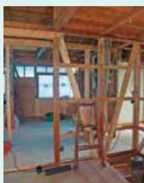
筋交いなどを設置
