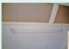
手すりの設置
