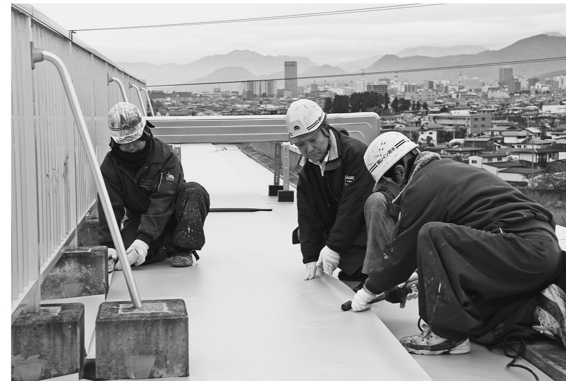
て弾性に優れた防水膜を作る。液体状の材料を使って仕上げる工法なので、複雑な形状をした場所でも継ぎ目のない完全な防水膜の施工可能だ。
